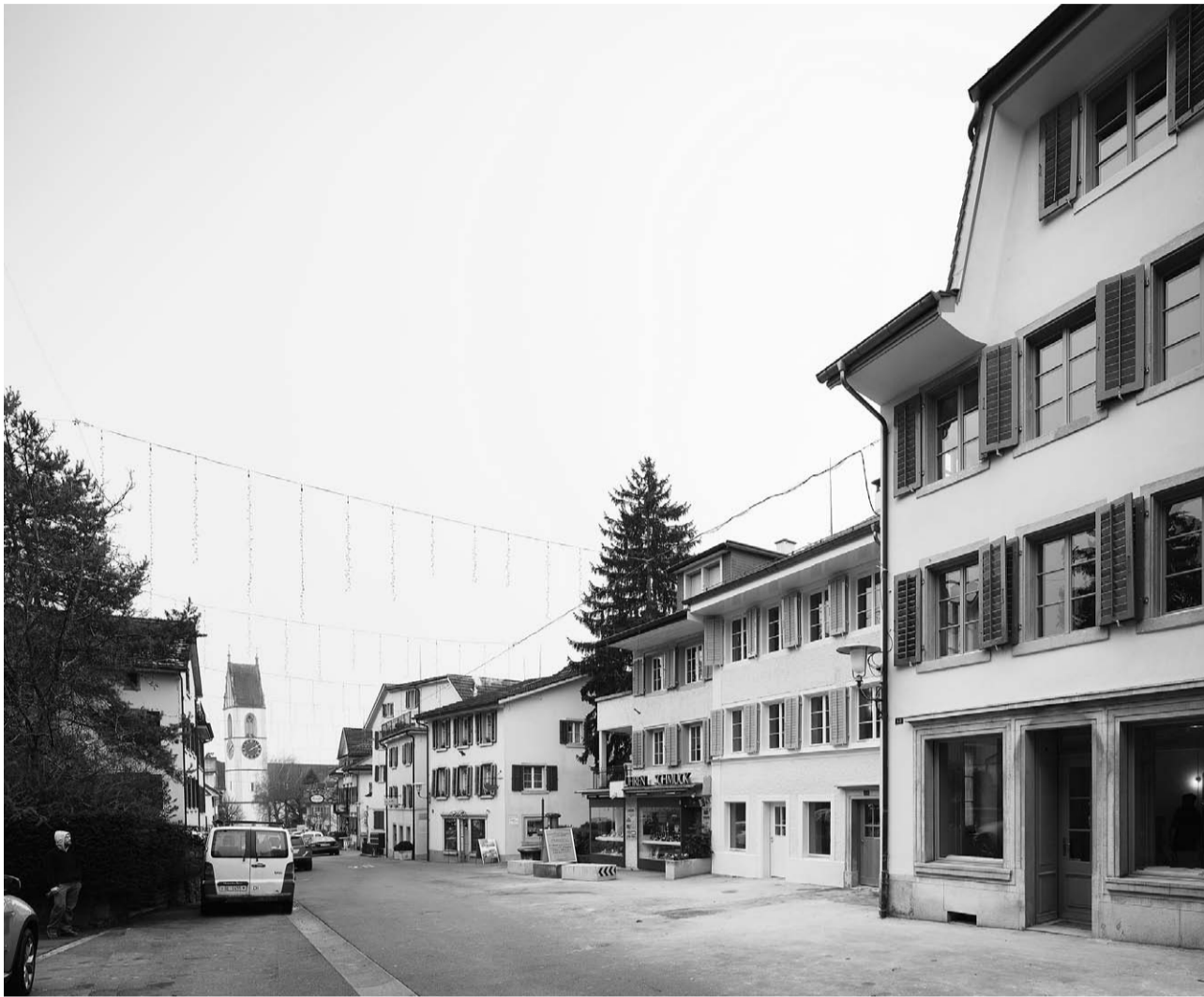
Die renovierten Häuser (rechts von der Bildmitte und am Bildrand).
